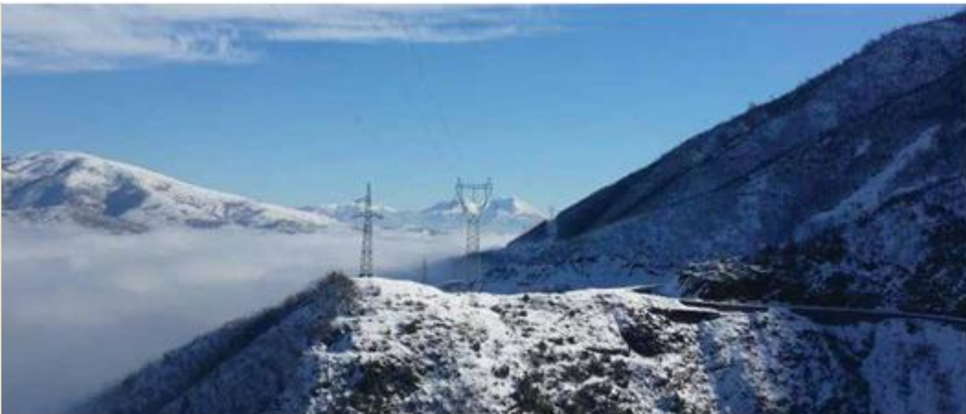
*Linjë 110 kV, ku është instaluar OPGW
