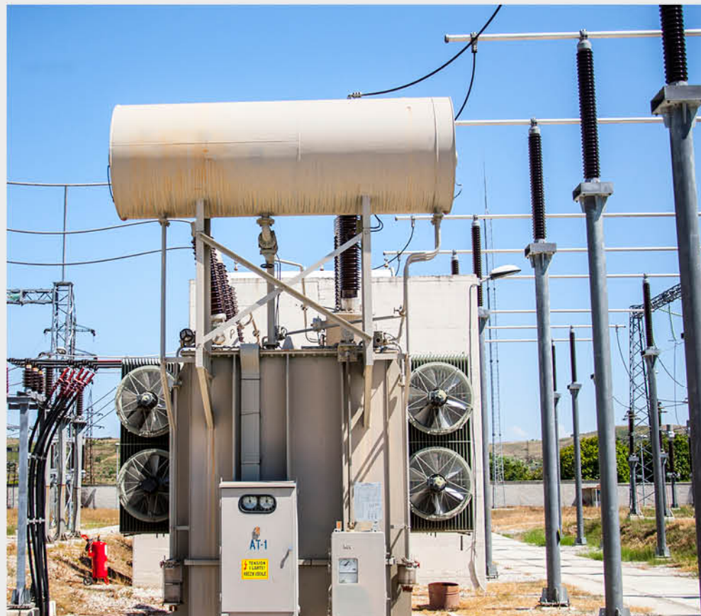
Instalimi i transformatorit të ri 150 MVA në nënstationin Zëmbllak
